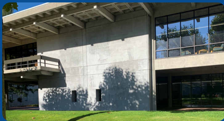
Mur de contreventement intégré à la protection parasismique d'une librairie universitaire
