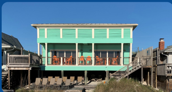
Élévation de structure pour atténuer les dommages causés par les inondations
