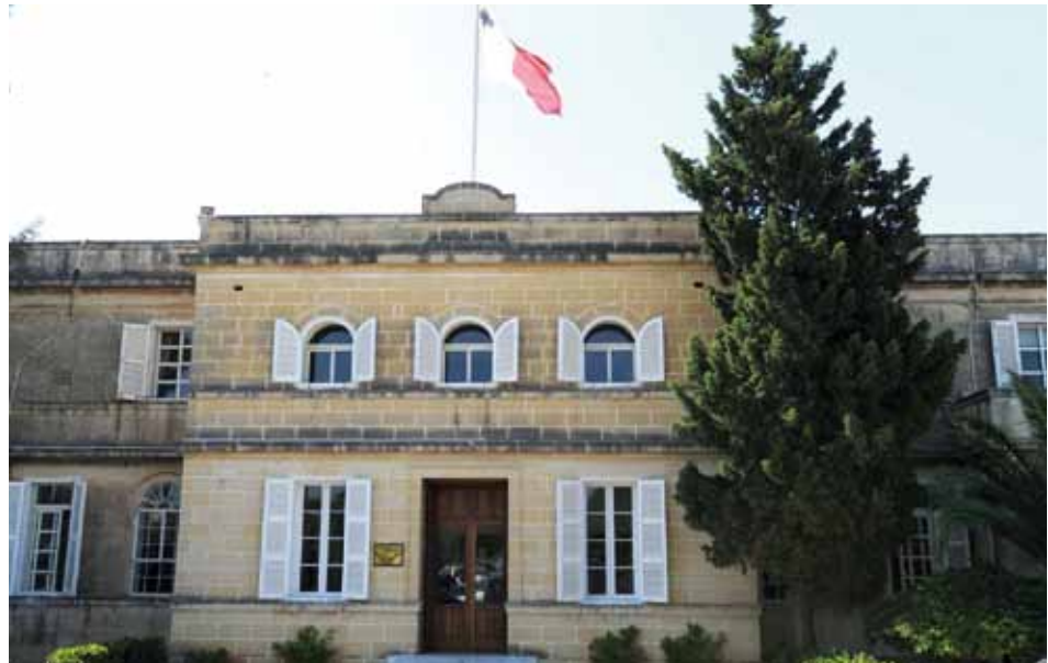
National Audit Office von Malta
