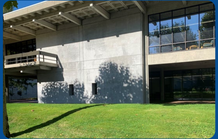
Scherwand als Erdbebenmassnahme einer Universitätsbibliothek
