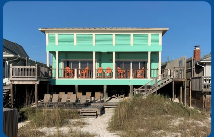
Höherlegung des Gebäudes gegen Hochwasserschäden
