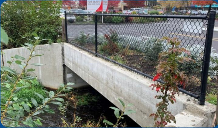
Водопрпускной канал с защитной стенкой, предотвращающей эрозию и позволяющей воде проходить под дорогой
